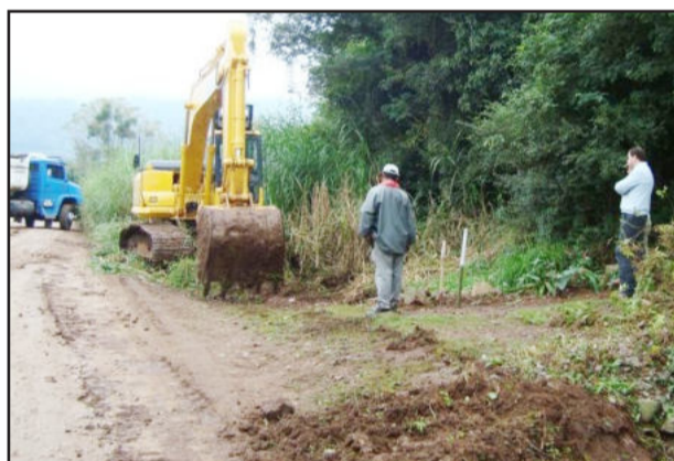
Início das obras na Linha 31 de Outubro
