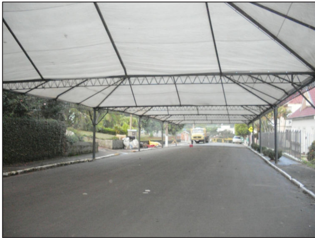
Trabalho de montagem das pirâmides foi concluído
