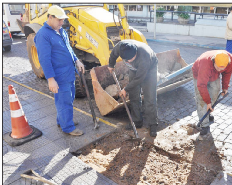
Obras no Centro para melhorar deslocamento
