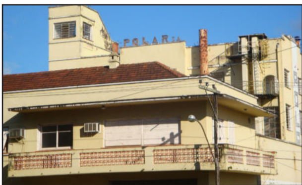
Área do prédio em que funcionará a futura sede da Amvat
