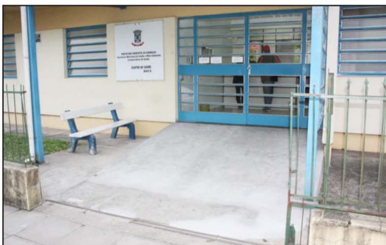
Rampa de acesso para cadeirantes
