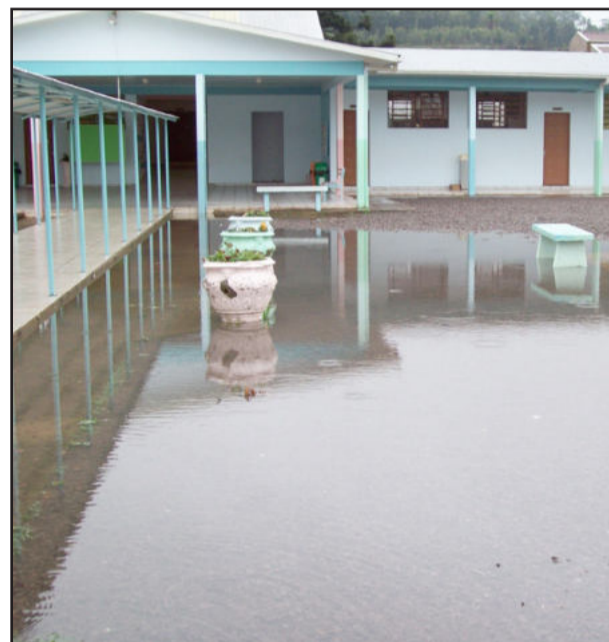
Pátio inundado na Escola Municipal Prefeito José Chies em Carlos Barbosa
