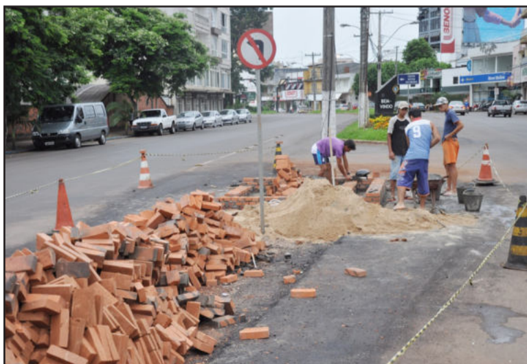
Construção da base do monumento iniciou nesta quarta-feira
