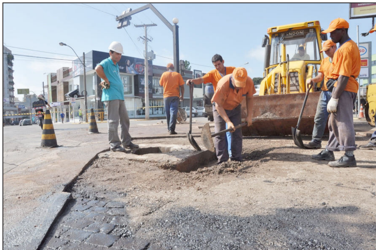
Local onde havia canteiro na Pasqualini sendo asfaltado
