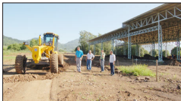
Equipe de Obras abre avenida que dá acesso ao Distrito Industrial
