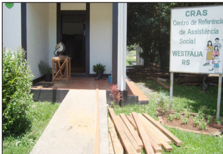
Assoalho está sendo trocado
