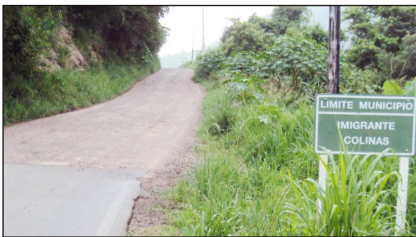
Obra era ambição antiga da comunidade
