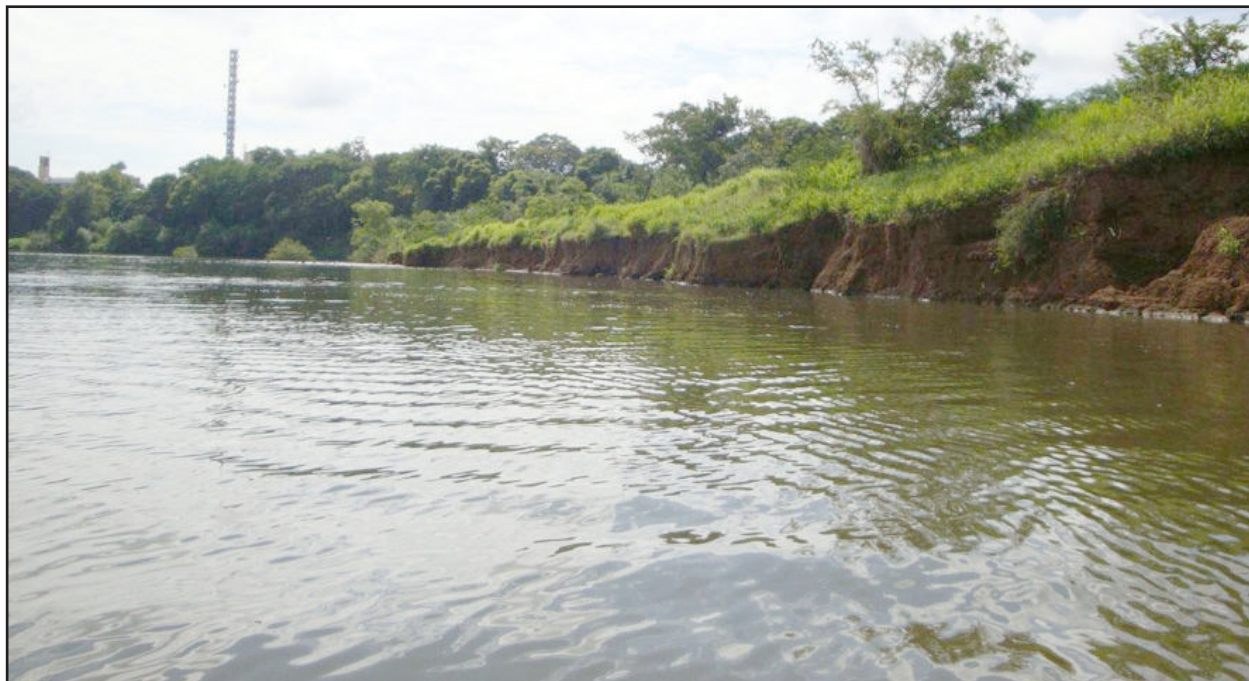
Obra irá conter erosão da barranca do rio
