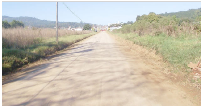
Rua Arno Hauenstein será pavimentada
