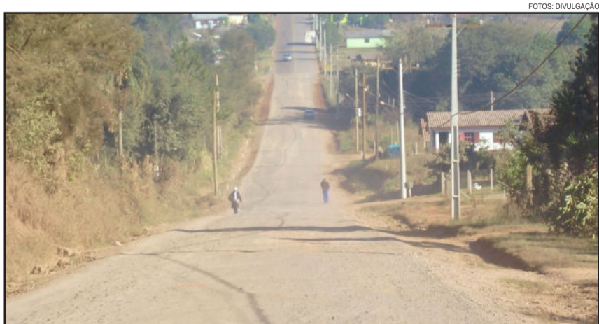
Trecho da Rua 4 de Julho também receberá pavimentação asfáltica
