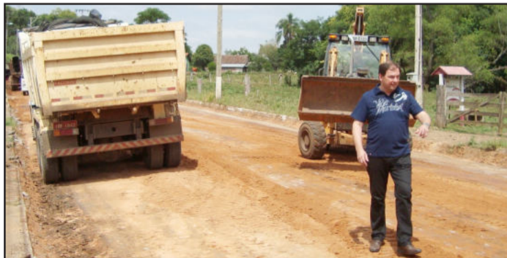
Prefeito Gilberto Keller acompanhou início da obra. Agora, entre Colinas e Imigrante é 100% asfalto
