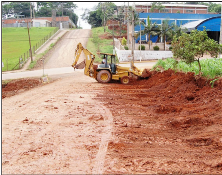
Avenida Amazonas recebendo canalização
