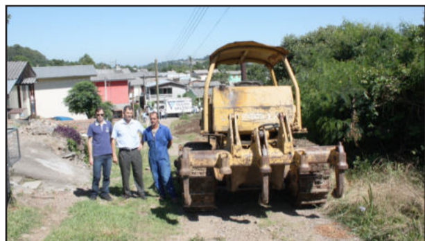
Obras iniciaram nesta terça-feira
