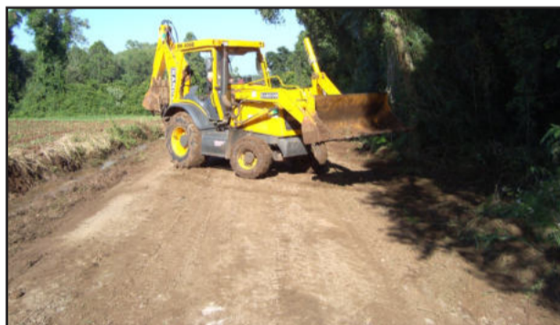
Máquinas reforçam o serviço
