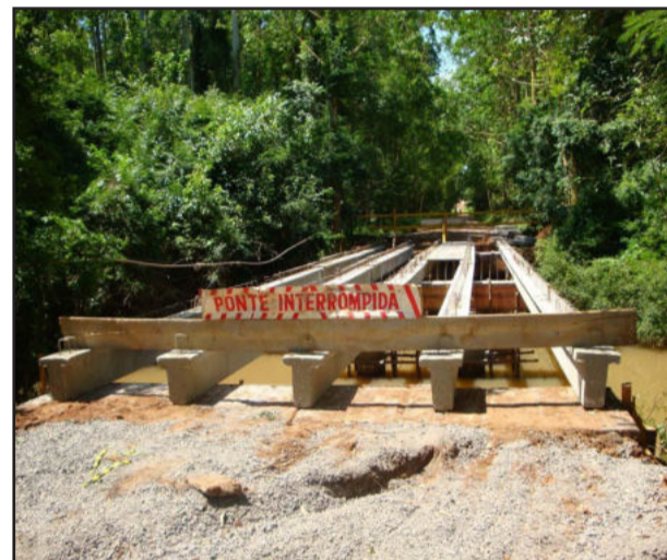
Ponte recebe vigas principais da estrutura
