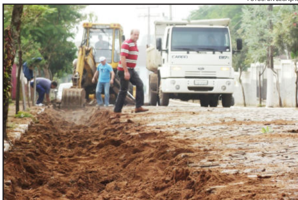
Obras começaram na Rua 4 de Julho
