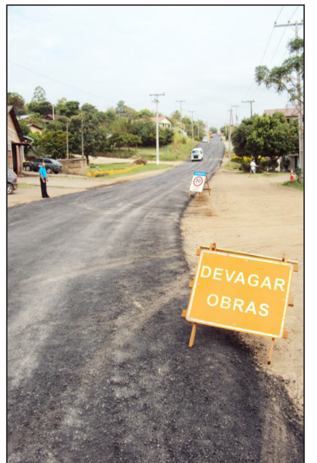
Recapeamento do acesso a Paverama
