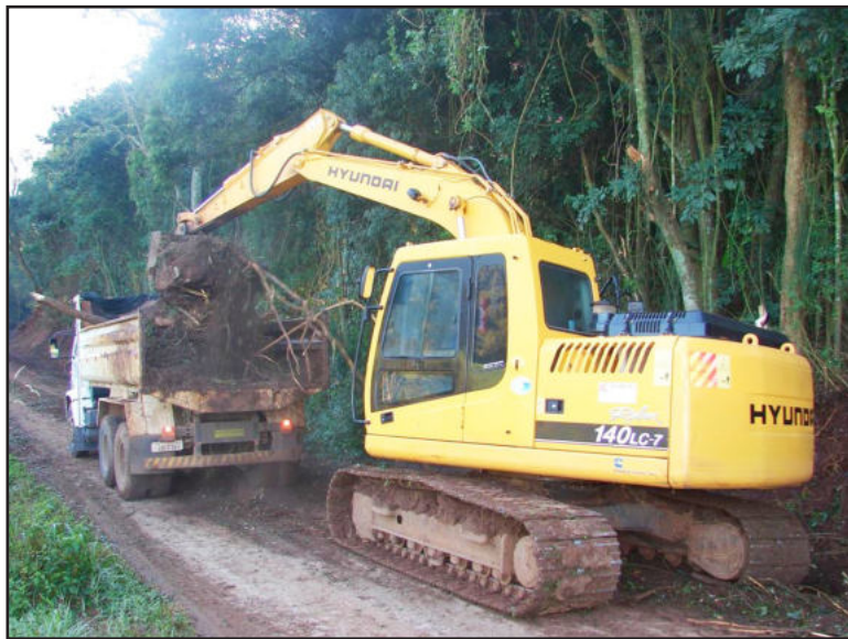
Cerca de 300 cargas de entulhos foram removidas das margens da estrada geral de Clara Alta
