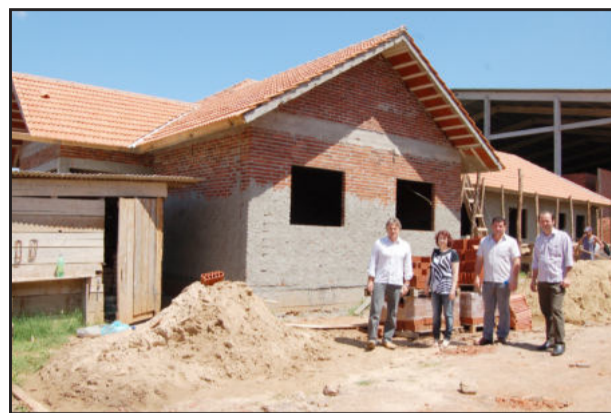
Construção do Posto de Saúde do Loteamento 8
