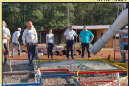
Construtora iniciou obra com formas metálicas. Página 4
