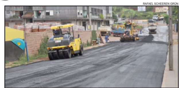
Rua Donga Menezes recebeu pavimentação asfáltica em 157 metros de extensão
