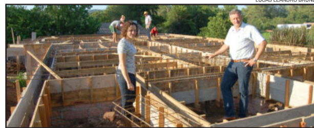
Obras do Posto de Saúde do Bairro Boa Vista avançam
