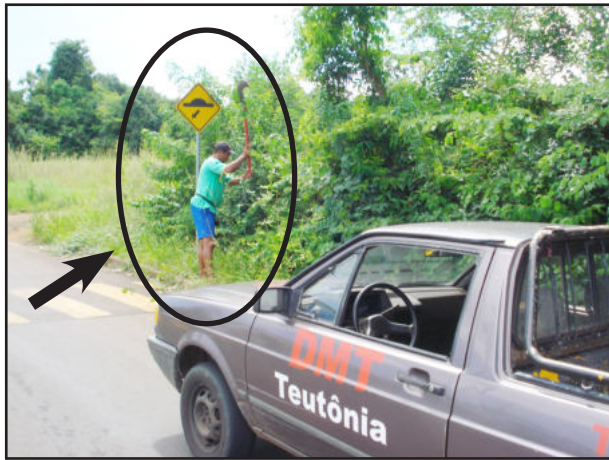
Limpeza na sinalização
