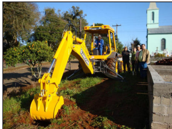
Retroescavadeira realizou o primeiro trabalho na sexta-feira
