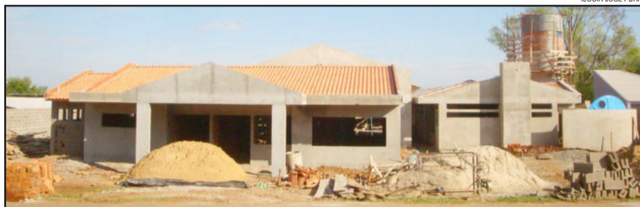
Emei Indústrias em fase de construção
