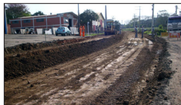
Obra está sendo concluída
