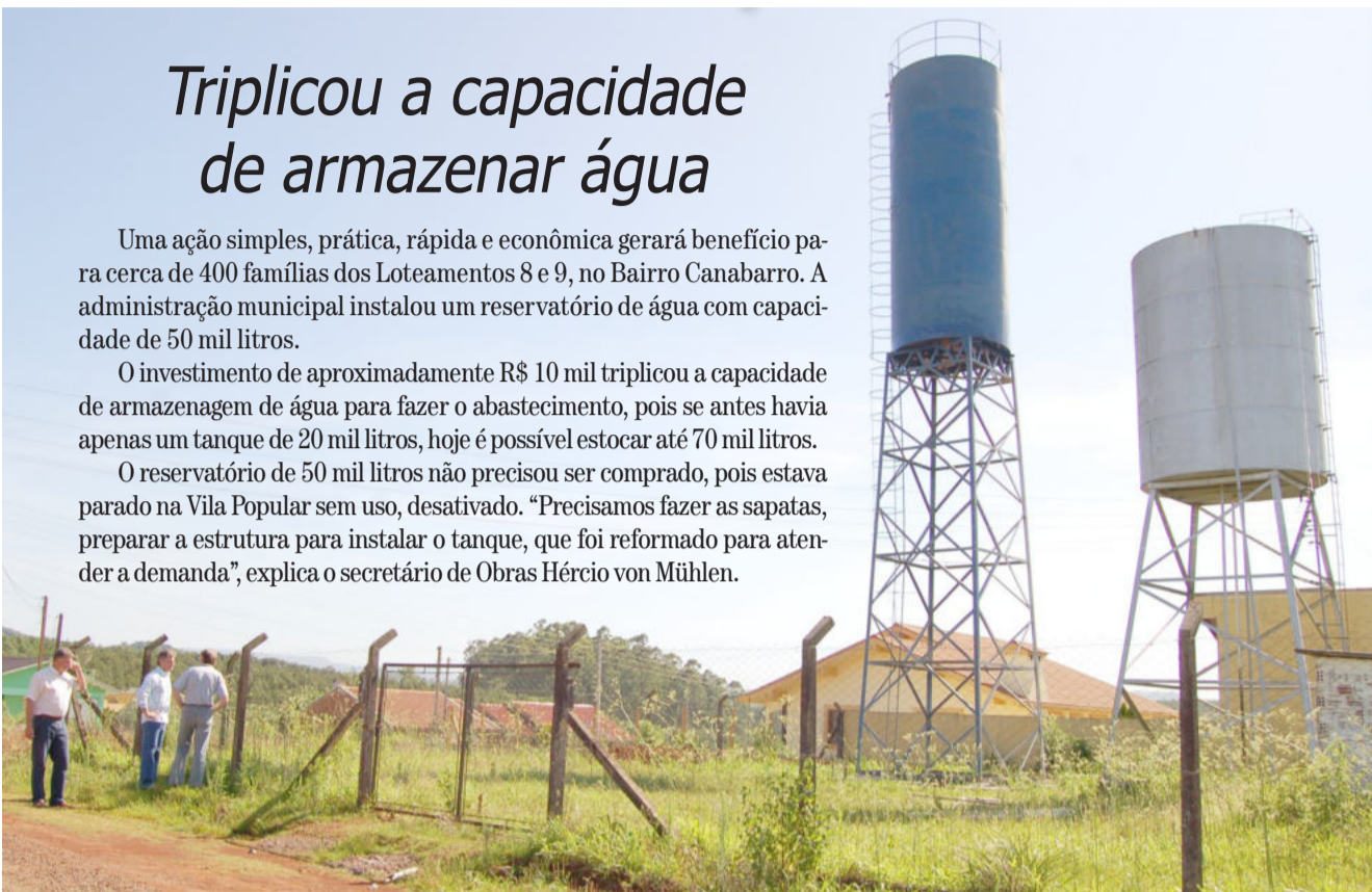
Implantação de caixa de água no Loteamento 8
