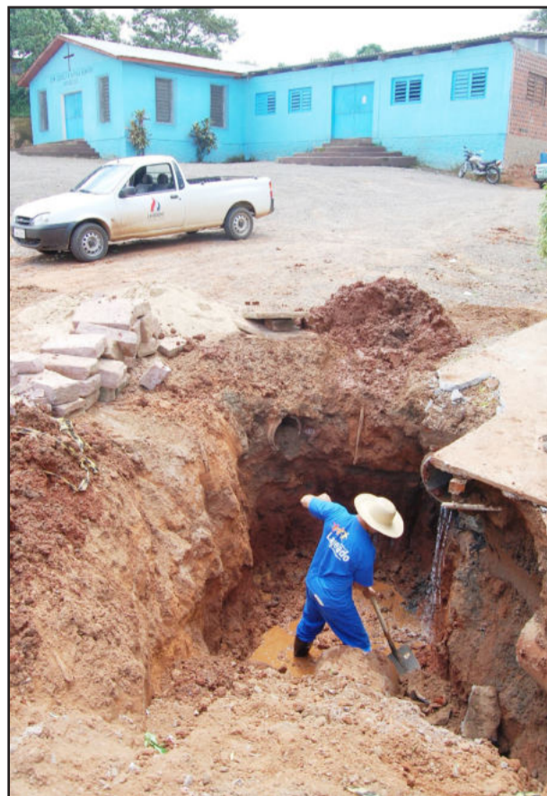
Troca de canalização na Rua Giuseppe Garibaldi no Santo Antônio
