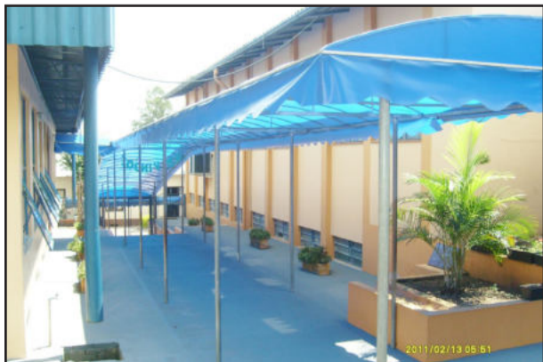
Toldo de acesso à Escola Municipal Ipiranga
