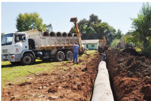
Campo do Bairro Jardim do Cedro recebeu obras de canalização
