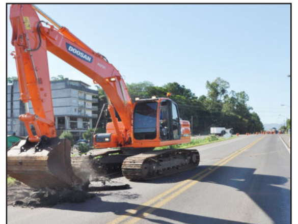
Obra do túnel sob ERS-130 foi iniciada nesta terça-feira
