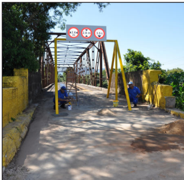
Ponte de Ferro com delimitadores de espaço sendo pintados
