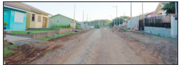
Começaram as obras para pavimentar a Rua Alvys Hoffstätter, em Canabarro
