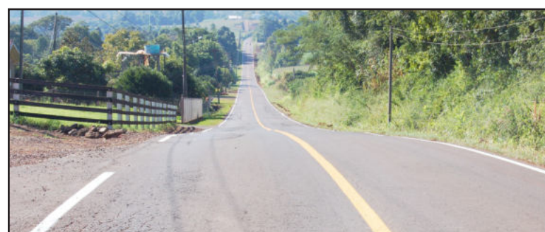
Trecho de Languiru a Linha Wink recebeu pintura completa da sinalização
