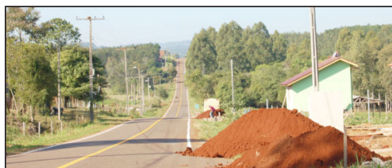
Asfalto de Linha Germano também recebeu a pintura da sinalização
