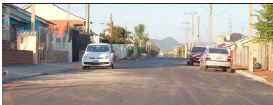
Rua Roberto Geib, no Bairro Alesgut, está pavimentada
