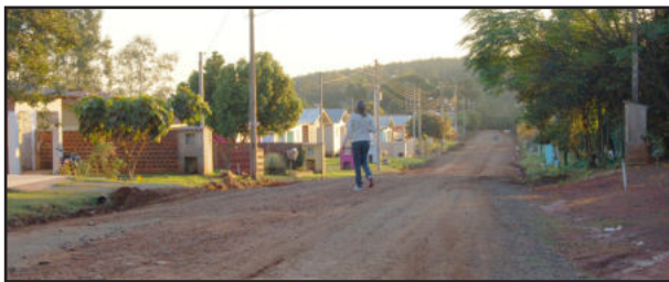
Iniciaram as obras na Rua Copacabana, na Vila Esperança
