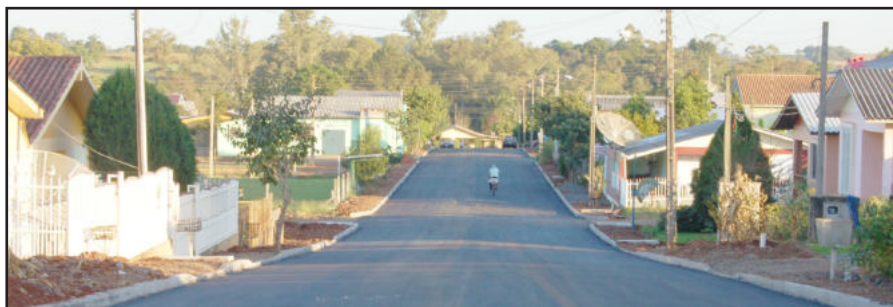
Pavimentação da Rua Werno Wiebusch, no Loteamento Castro, está concluída
