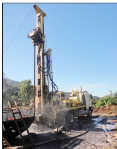
Perfuração de poços artesanais para comunidades de áreas rurais
