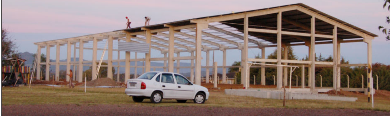
Ginásio da EMEF Alfredo Schneider vai tomando forma no Bairro Teutônia
