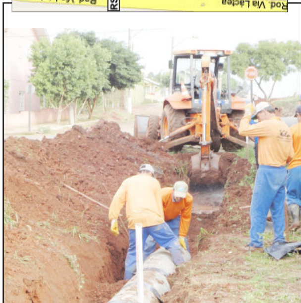
Início das obras de pavimentação da Rua 2 Leste
