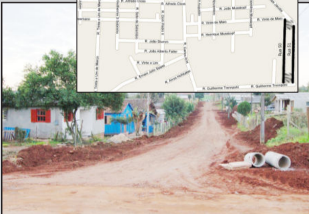
Início das obras de pavimentação da rua 50
