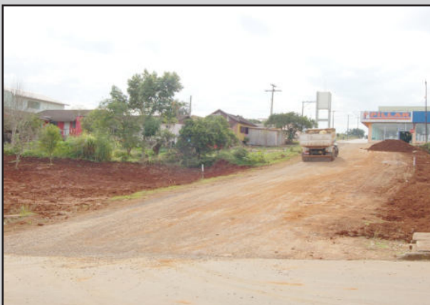
Rua 31 de Março em Canabarro antes da pavimentação
