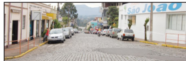
Rua 3 de Outubro em Languiru antes do capeamento asfáltico
