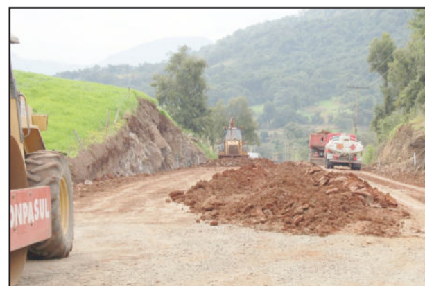
Nas imediações do Restaurante Matinho, corte na elevação exige mais trabalhos de terraplenagem
