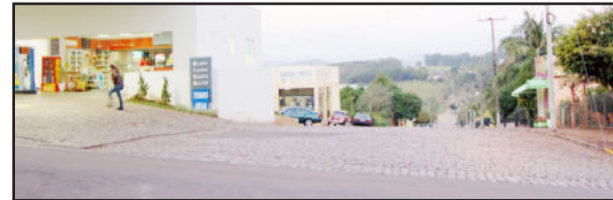
Rua Salgado Filho antes do capeamento asfáltico
