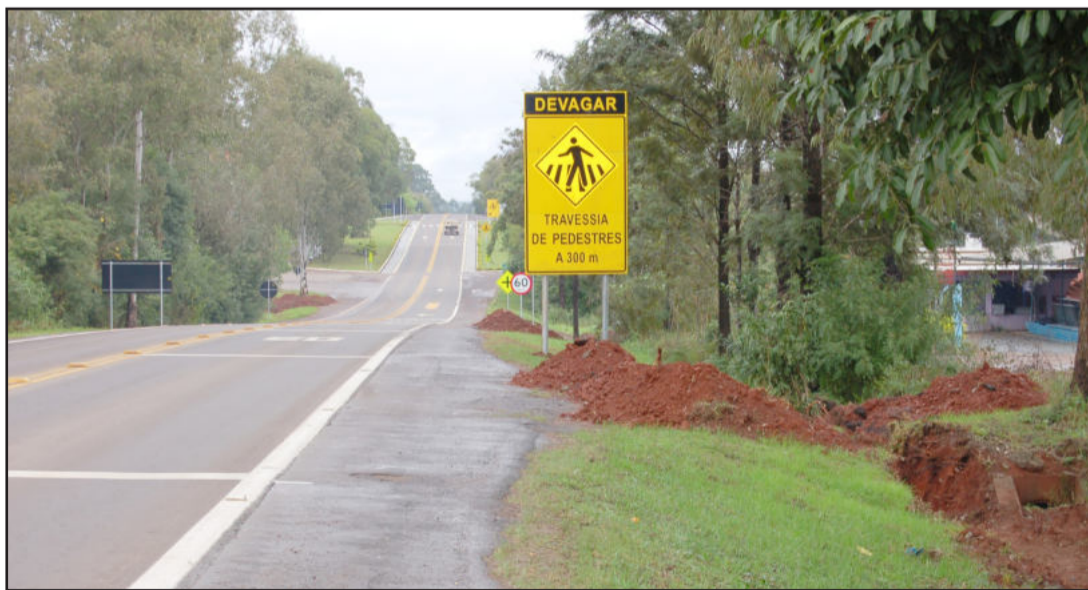
Sulvias cavou valetas e fechou acessos à rodovia próximos ao trevo
