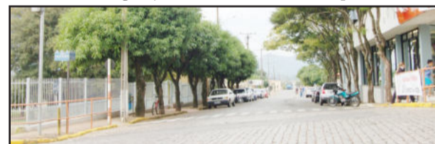
Rua 25 de Julho em Languiru antes do capeamento asfáltico
