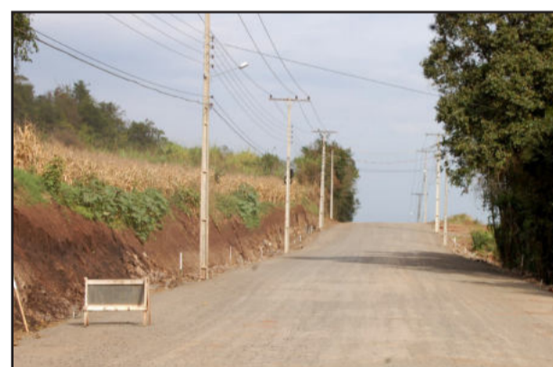
Alguns trechos da Estrada Velha já estão prontos para receber a capa asfáltica
