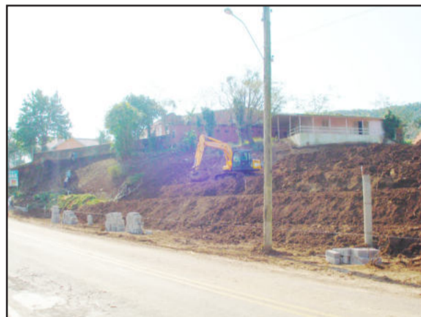
Obra na entrada da cidade
