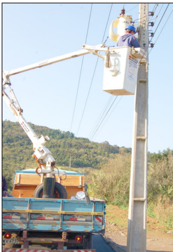
Administração municipal instala rede de iluminação pública
