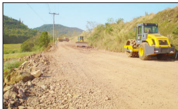
Obras estão em andamento
