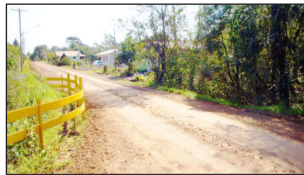
Ponte localizada na Glória terá galeria de concreto pré-moldado
