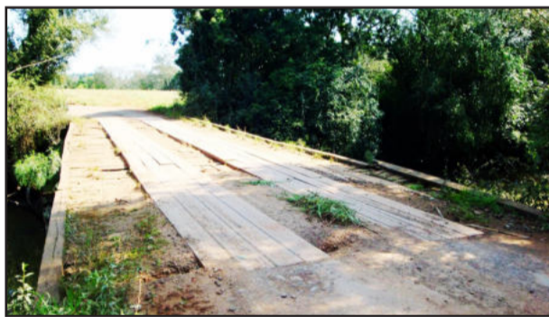
Tabuleiro e guarda rodas serão substituídos no pontilhão de São Jacó
