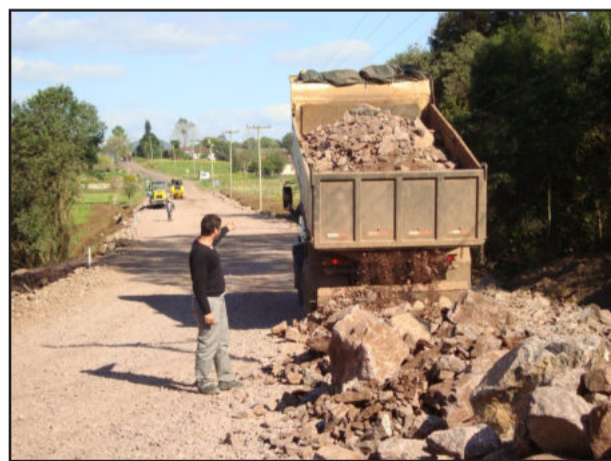
Estrada recebe boa base para resistir ao trânsito
