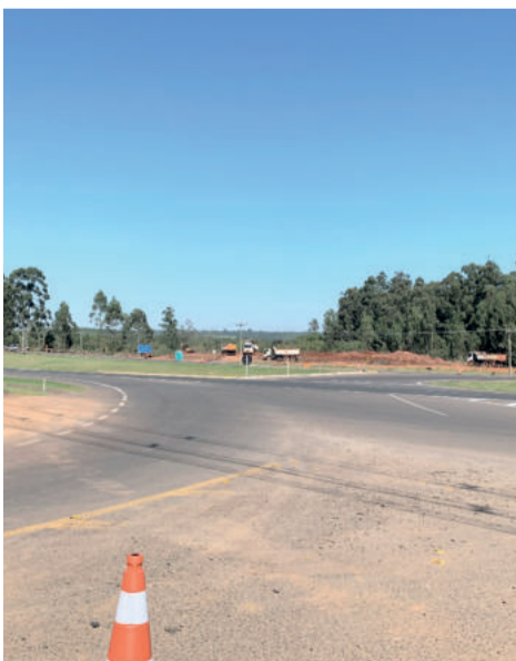
Obras já iniciaram na pista sul, sentido interior – capital
