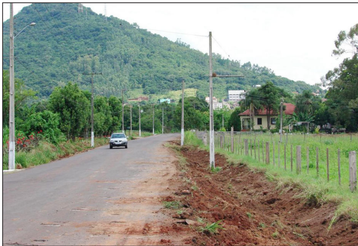
Obra na Várzea, no Bairro Teutônia, segue etapa de limpeza das laterais
