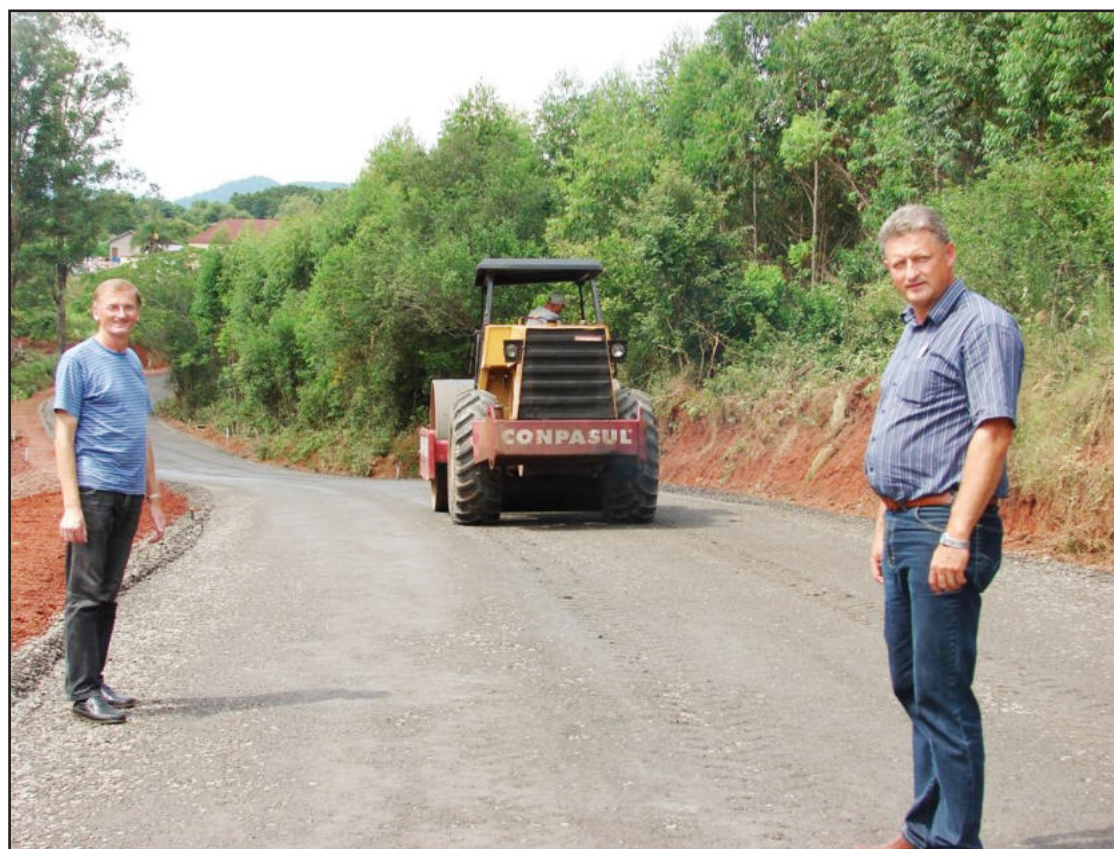
Obra na estrada geral de Posses já está na fase de imprimação
