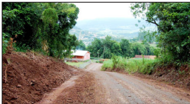
Acesso à Castro Alves recebeu melhorias
