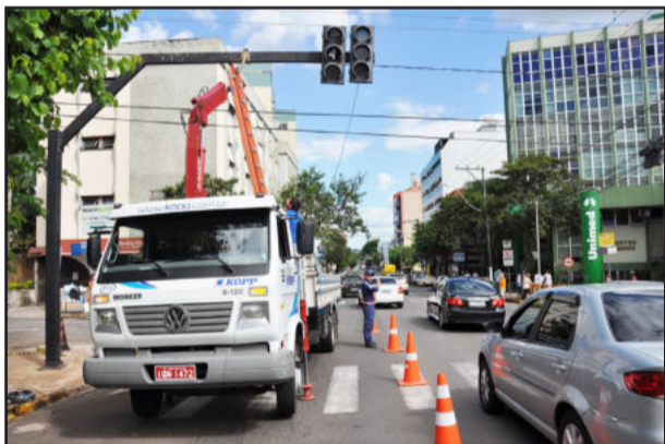
Semáforo localizado entre Av. Benjamin Constant e Rua Pinheiro Machado foi reinstalado nesta segunda-feira
