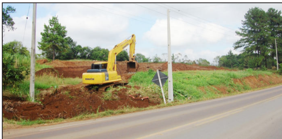
Terreno já está sendo preparado para receber a UPA
