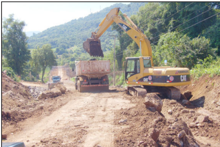
Escavadeira e caminhões diminuem altura de morro para assegurar mais segurança
