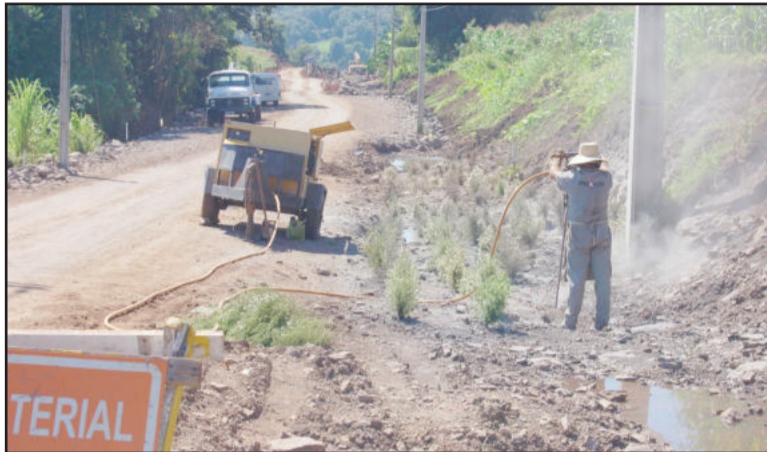
Detonação de pedras para facilitar a preparação da cancha
