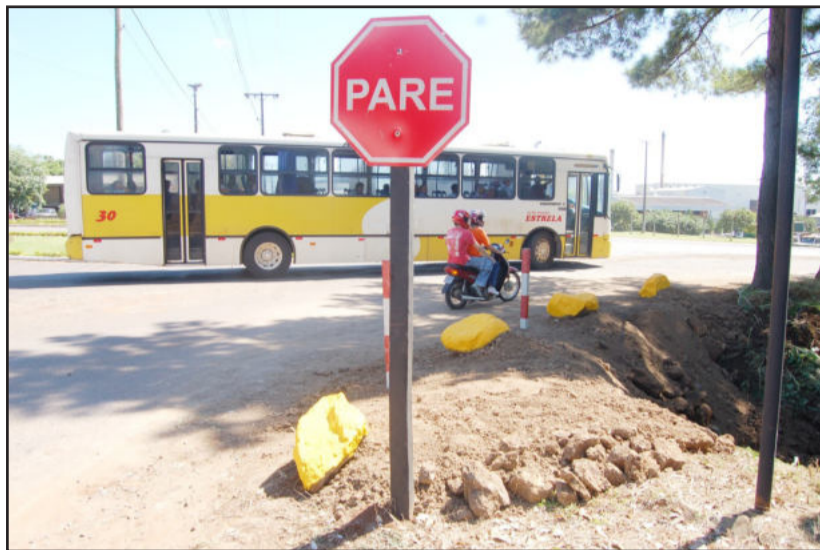
Alargamento no trevo de acesso aos bairros Languiru e Alesgut melhora condições para o fluxo de veículos
