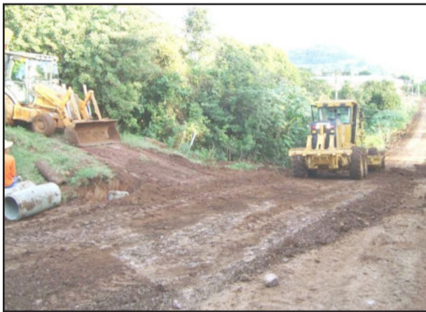
Via urbana está sendo asfaltada
