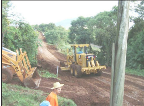
Obras de pavimentação iniciaram esta semana
