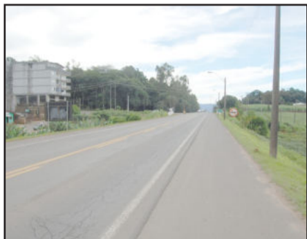
Viaduto será construído na RS-130, proximidades do Posto do Arco
