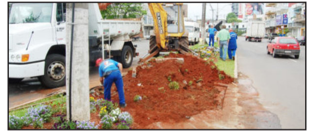
Canteiro central está sendo adequado para receber retorno e semáforo
