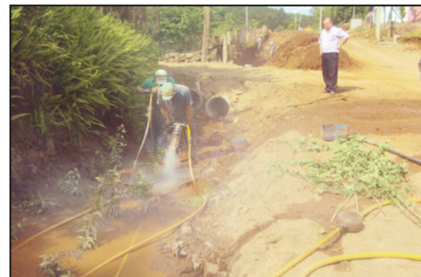
Prefeito acompanha trabalhos de pavimentação das ruas 4 de Julho e Crispim Franklin de Vargas
