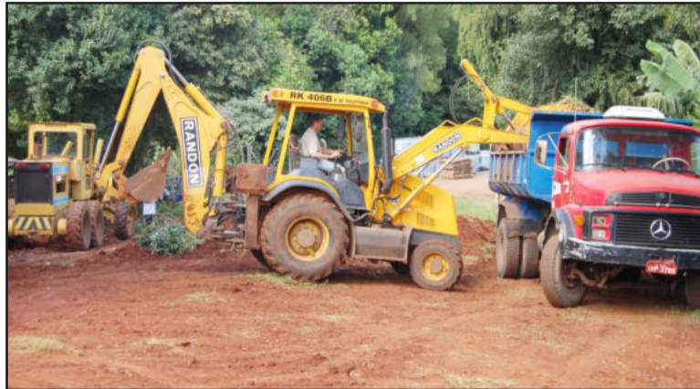
Abertura do novo acesso para a Couros Bom Retiro, em Canabarro
