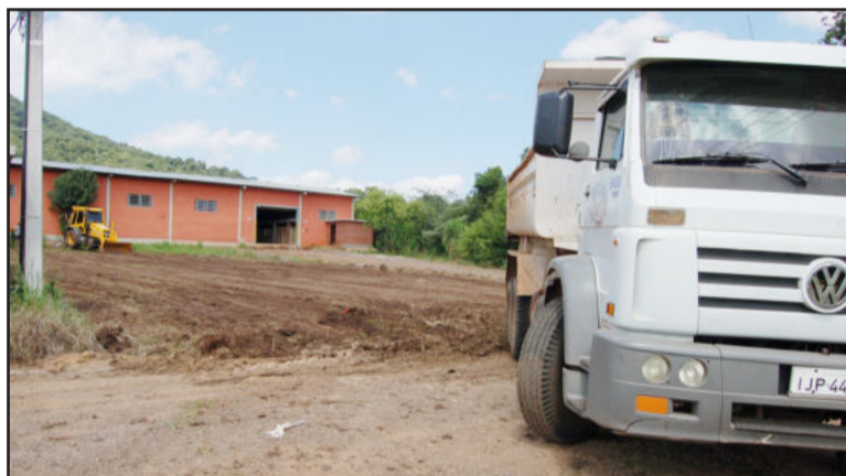
Terraplenagem para a ampliação da fábrica de móveis Formallar
