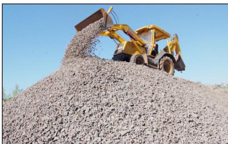
Estoque será utilizado na recuperação de estradas
