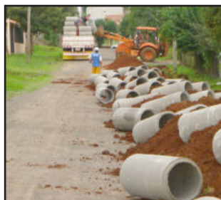
Pavimentação com bloquetes de concreto na Rua Aldino A. Sulzbach
