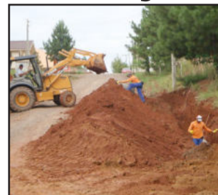
Rua Cerro Azul terá trecho com pavimentação asfáltica
