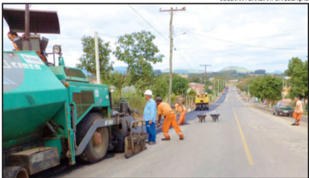
Imprimação asfáltica do acostamento foi executada essa semana
