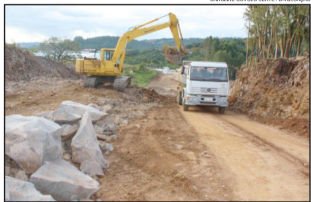
Obras de melhorias no acesso da empresa Vinhedos Transportes
