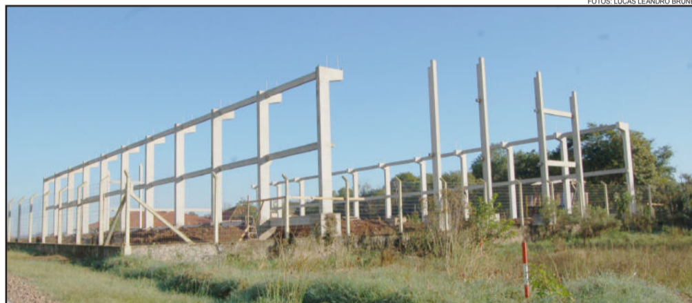
Estrutura de pré-moldados dá ideia da dimensão do ginásio da EMEF Alfredo Schneider
