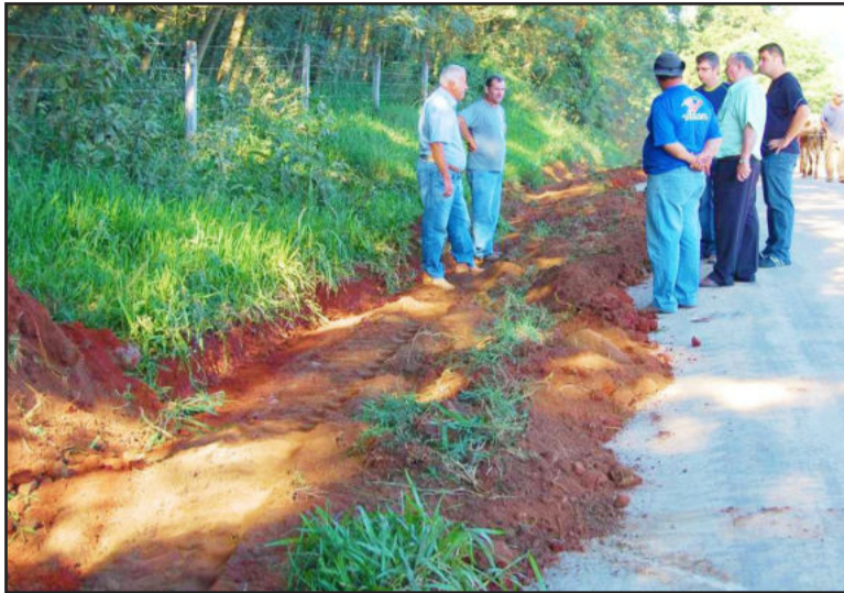
Representantes da administração municipal e da construtora conversam sobre início dos trabalhos
