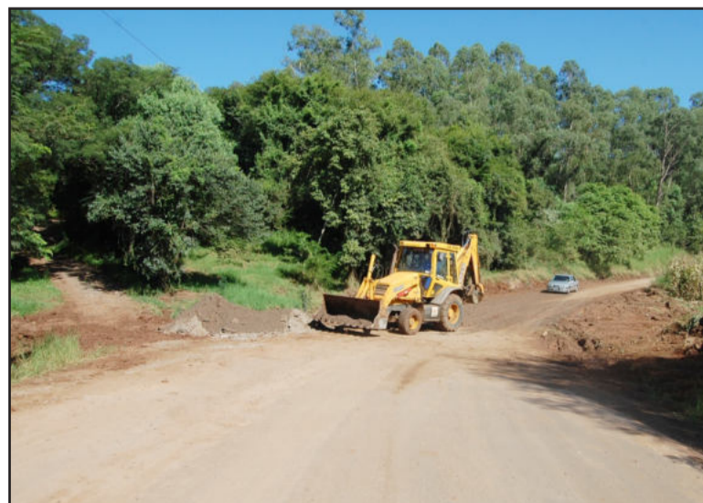
Canalização na Rua Pedro Theobaldo Breitenbach
