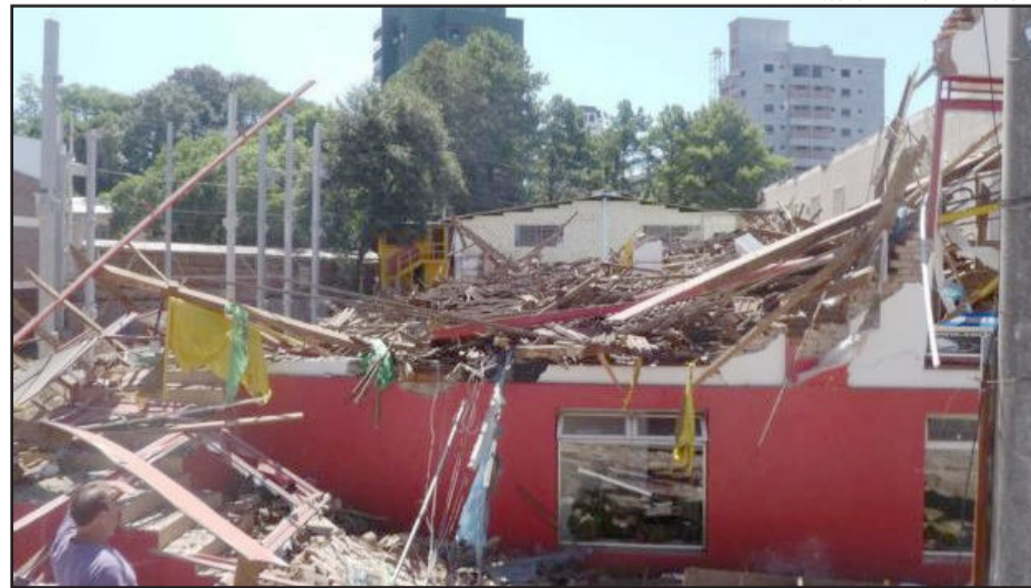
Prédio desabou ontem pela manhã, mas não deixou feridos
