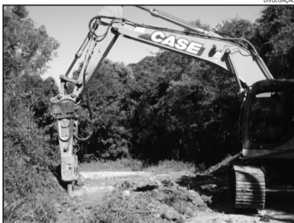
Estradas recebem melhorias - detonação de pedras
