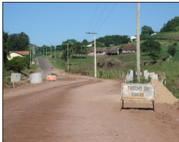
Base com compactação para o asfaltamento
