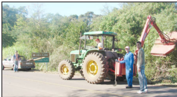
Roçada na RS-419 entre Teutônia e Poço das Antas
