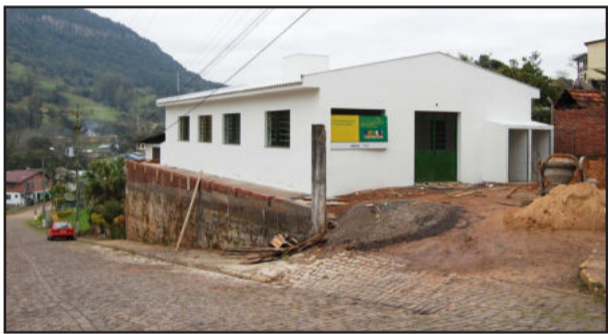
Nova unidade de Saúde deverá estar concluída em 30 dias
