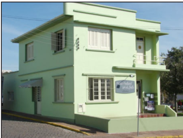
Prédio após a reforma
