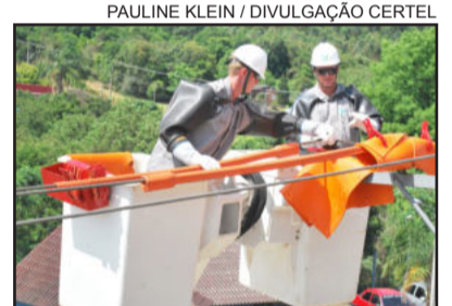
Manutenção com linha energizada afasta o risco da falta de luz para manutenção em redes ligadas
