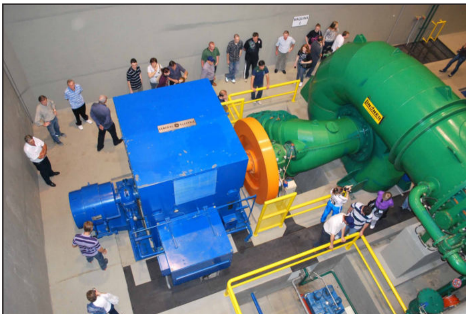
Visita à casa de máquinas da usina
