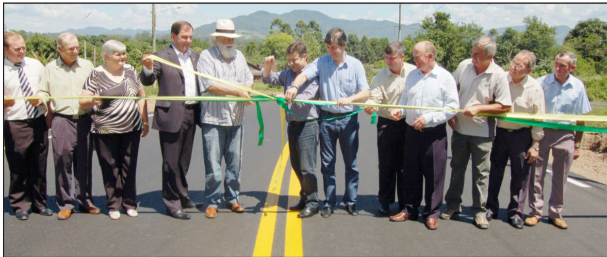
O desenlace da fita no início do novo asfalto
