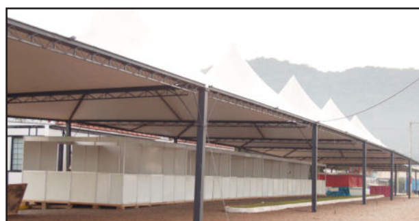
Praça de alimentação está em fase de montagem
