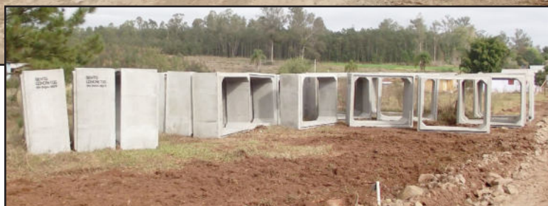
Estrutura da galeria está preparada para ser implantada
