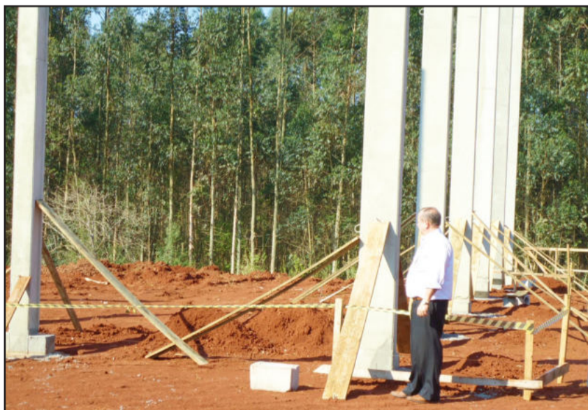
Prefeito acompanha obras de construção de cancha coberta na Cidade Baixa
