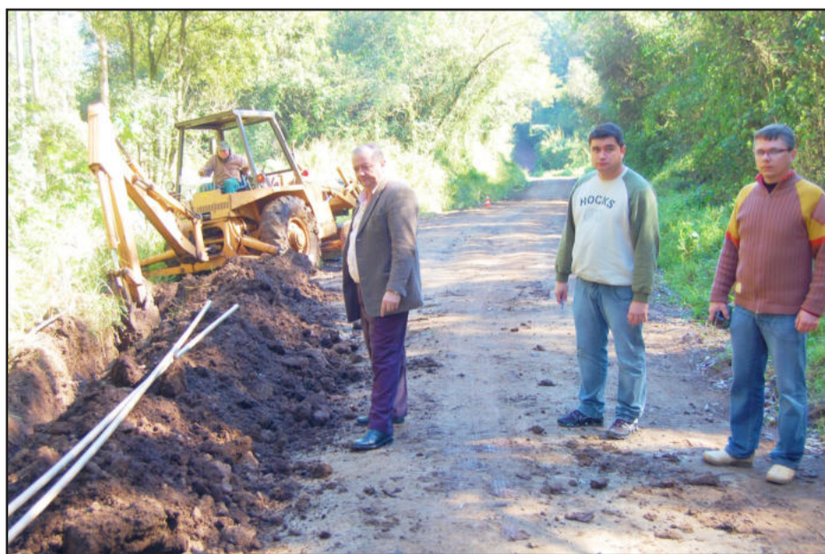
Prefeito e engenheiros acompanharam a execução das obras
