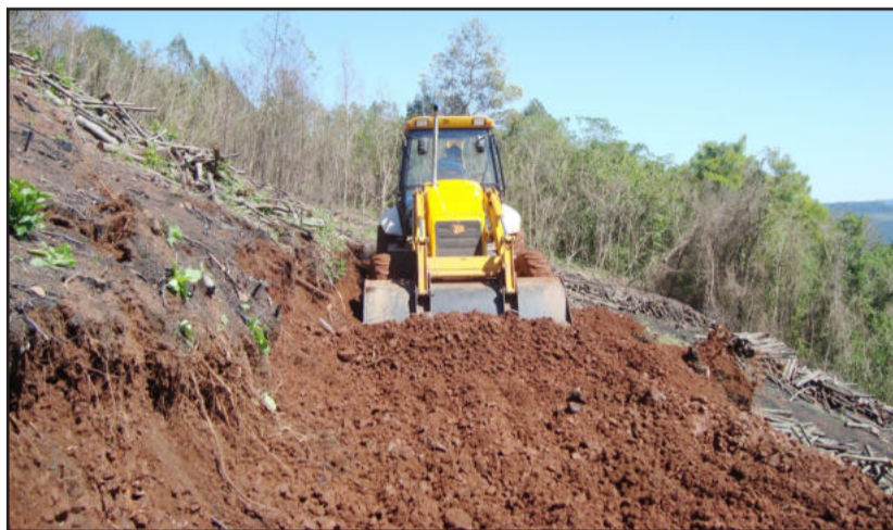
Serviço da retroescavadeira tem grande procura
